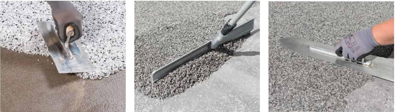
Das Mischgut wird in den üblichen Schichtdicken (ca. 6 mm), mit einer Stiftrakel grob verteilt und anschließend verdichtet und geglättet. Optional: Die Kopfversiegelung erfolgt durch den Auftrag von Natursteinteppichharz **PU 1K** mittels Microroller.
