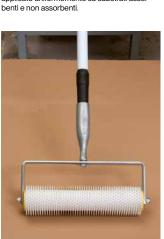
3. Per garantire un flusso di lavorazione ottimale, disareare l'impasto dell'intonaco SL 52 utilizzando un rullo dentato.
