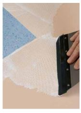
4. Con il collante per pavimenti di design D 495 o il collante Quattro Floor D 444 o il collante speciale X-Bond MS-K 499, è possibile incollare pavimenti elastici e in tessuto.
