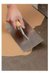
2. Applicare uno spessore desiderato di impasto di stucco rapido SL 52 sullo strato di supporto già preparato con il primer, se possibile in una unica lavorazione.
