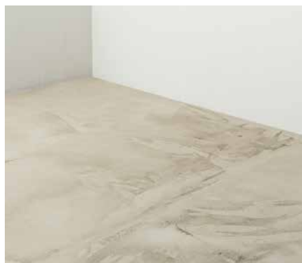
Verlegefertiger Untergrund
